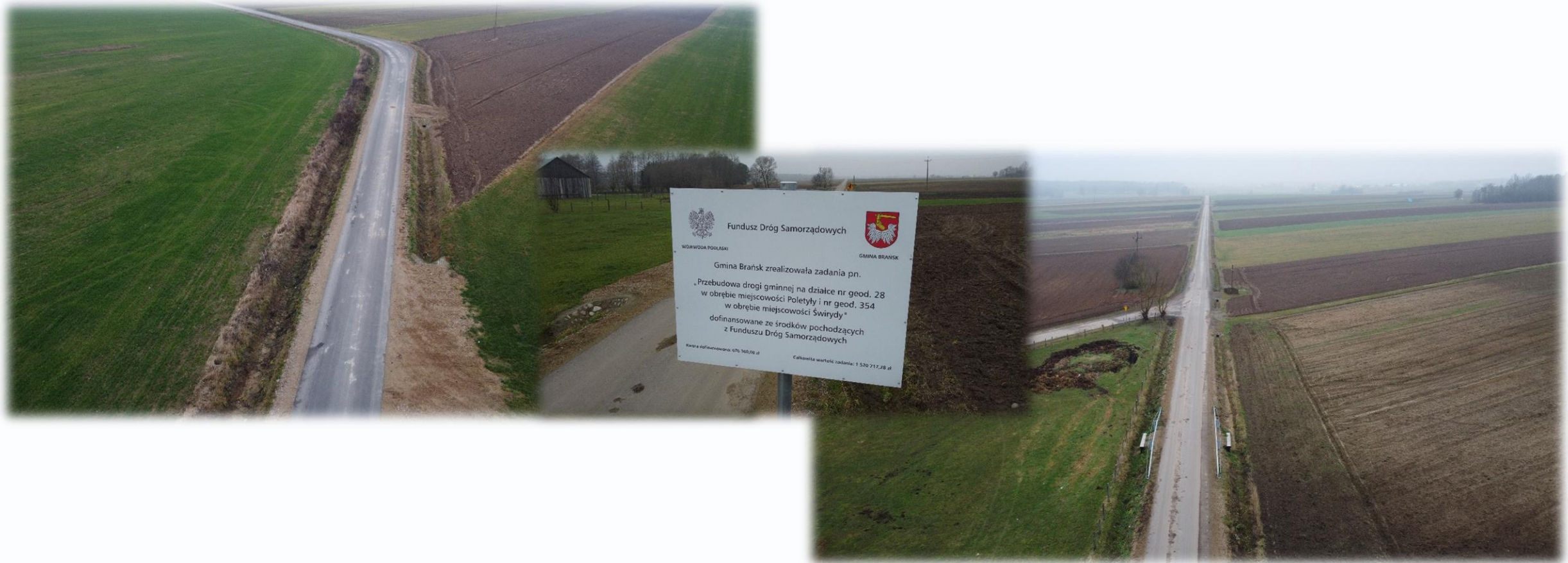
Przebudowa drogi gminnej na działce nr geod. 28 w obrębie miejscowości Poletyły i nr geod. 354 w obrębie miejscowości Świridy
