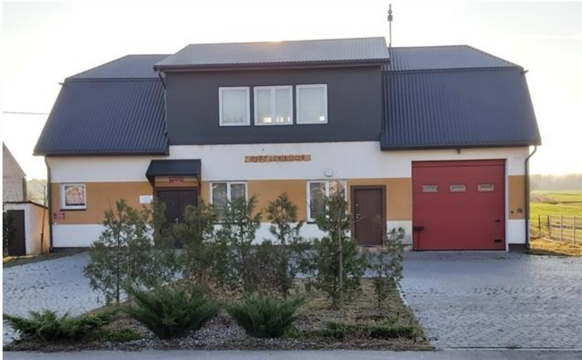
Wymiana pokrycia dachowego OSP Lubieszcze
